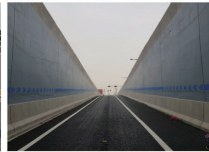
안성 스타필드 진입도로 지하차도
