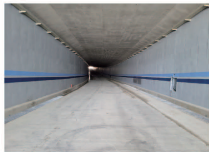
양재천 우안도로 지하차도
